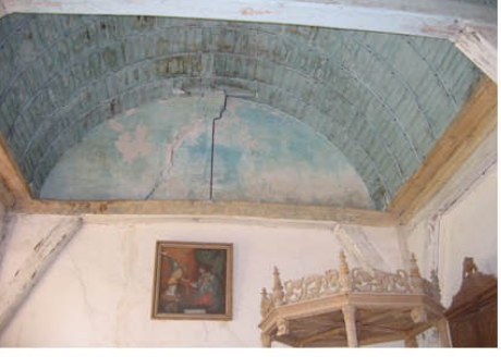
Voûte de chœur étoilée
